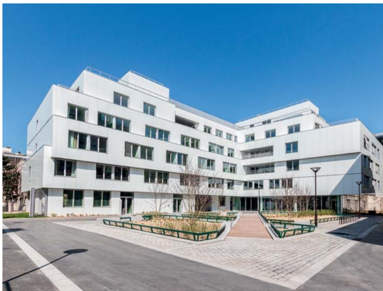
Víceúčelový objekt s byty a pečovatelskou službou pro seniory na rohu rue de Lourmel a rue de l'Eglise v Paříži.
